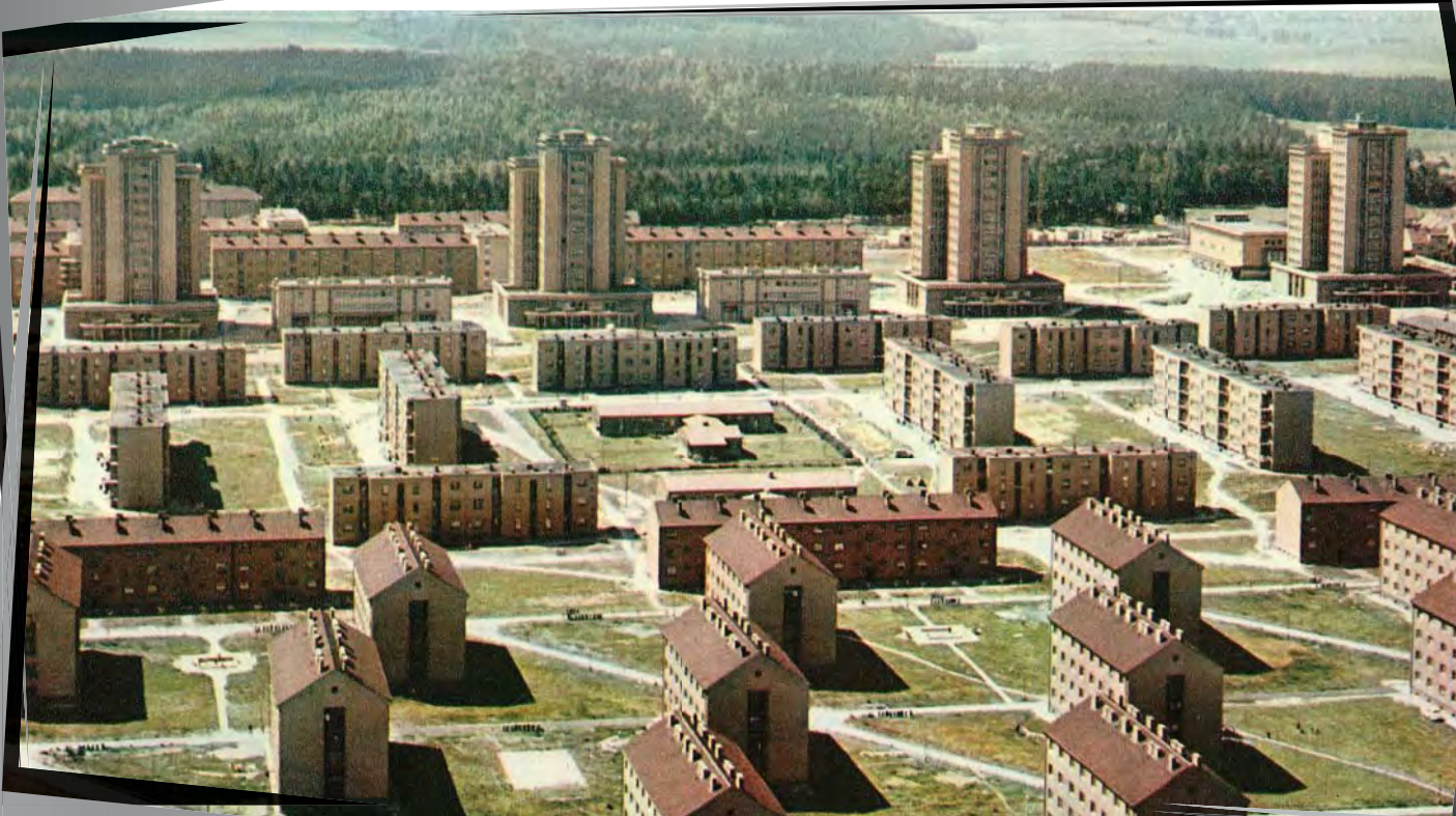
Severní část sídliště Vítězného února s linií věžových domů, počátek 70. let (pohlednice)
