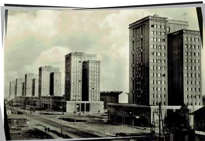
Věžové domy krátce po dokončení, kolem nich stále ještě stojí budovy stavby (konec 50. let, pohlednice)
